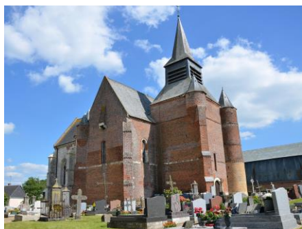
Eglise Saint-Martin de Burelles
